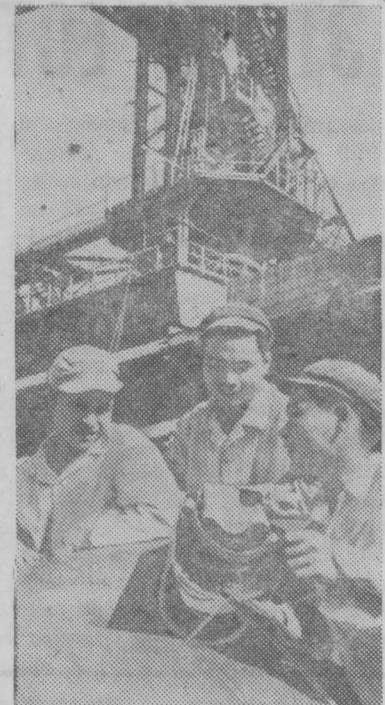
Демократическая Республика Вьетнам. Сварщики, работающие на строительстве металлургического комбината Тхай Нгуен, досрочно закончили сварку корпуса пылеотделителя доменной печи № 3.
