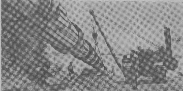
НА СНИМКЕ: бригада трубоукладчиков ведет подготовку плети к спуску под воду. Фотохроника ТАСС.
