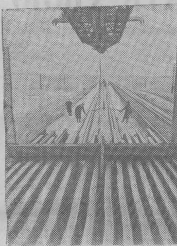
В дагестанской АССР реконструируются стальные магистрали. Ведется укладка бесстыкового пути. Отрезки рельсов длиной 12,5 метра заменяются плетями длиной восемьсот метров. Работы эти выполняют путевая дорожно-машинная станция № 3 Северо-Кавказской железной дороги. После реконструкции скорость поездов увеличится до 120 километров в час.
