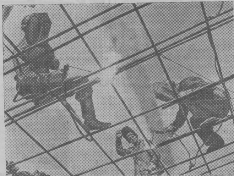
Южно-Казахстанский край. Заслуженным авторитетом пользуется на сооружении Чардарьинского гидроузла бригада арматурщиков, которой руководит коммунист Владимир Черенков. Дружный коллектив ежедневно перевыполняет нормы выработки. За высокие показатели в труде передовые строители недавно удостоены почетного звания бригады коммунистического труда. НА СНИМКЕ: бригада В. Черенкова за сваркой арматуры в камере водосброса.
