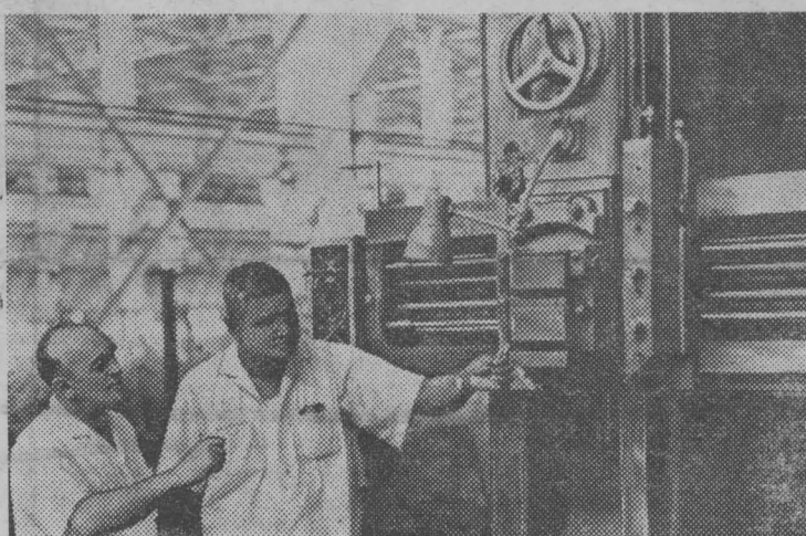
Индия. В Ранчи (штат Бихар) при техническом и экономическом содействии СССР сооружается первый в стране завод тяжелого машиностроения.
