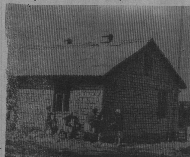
Строительство дома из грунтоблоков
