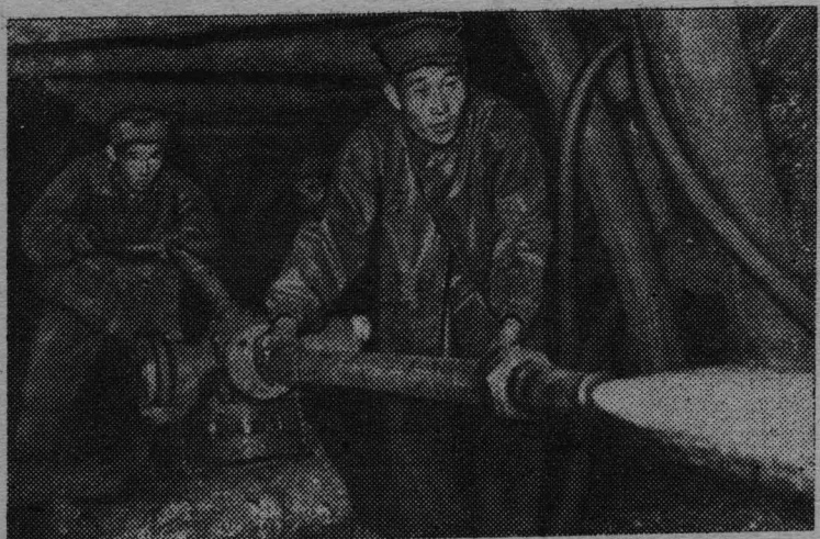
Корейская Народно-Демократическая Республика. На шахте Хёнвон в провинции Южный Пхёнан добыча угля осуществляется с помощью гидромониторов. На снимке: гидродобыча угля на шахте. Фото Хан Чон Сика. Фотохроника ЦТАК.
