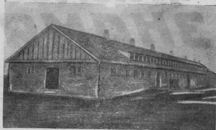
На снимке: вновь строящийся телятник на второй ферме совхоза «Краснинский». Стены выложены из камня-плитняка, крыша — из толстого гофрированного профлистона.
