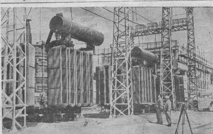
**Московская область.** В районе Ногинска заканчивается строительство подстанции, предназначенной для приема электроэнергии с Куйбышевской гидроэлектростанции. Первоначальное напряжение в 400.000 вольт здесь будет понижаться до 220.000 и 110.000 вольт. Подстанция полностью оснащена отечественным оборудованием.
