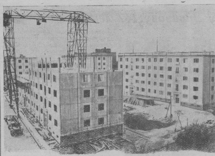
В Чехословацкой Республике внедряется метод строительства домов из готовых панелей. После успешных опытов в г. Готвальдова (Моравия) сейчас ведется сооружение из панелей шести 40-квартирных домов в одном из районов чехословацкой столицы Праги. Части стен или целую стену комнаты укладывают при помощи больших подъемных кранов.
