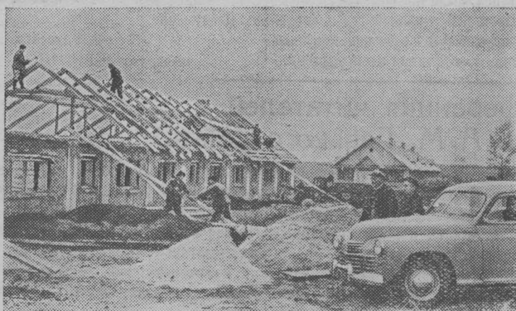
Алтайский край. В колхозе «Память Ленина» Марушинского района работает несколько строительных бригад. За два года они построили коровник на сто голов, здание электростанции, гараж, мастерские, кузницу, два зернохранилища, птичник. На снимке: строительство телятника в колхозе «Память Ленина». Фотохроника ТАСС.
