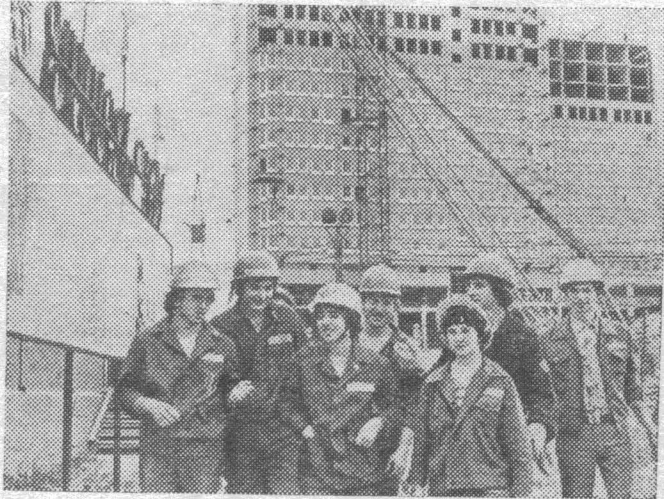
Москва, на Дмитровском шоссе строители СУ № 67 треста Мосстрой № 14 возводят олимпийский объект — гостиницу «Спутник» (на снимке). В 24-этажном корпусе будут размещены номера для гостей Олимпиады на 1600 мест, конференц-зал на 400 мест. Фото В. Егорова и А. Стужина (Фотохроника ТАСС).
