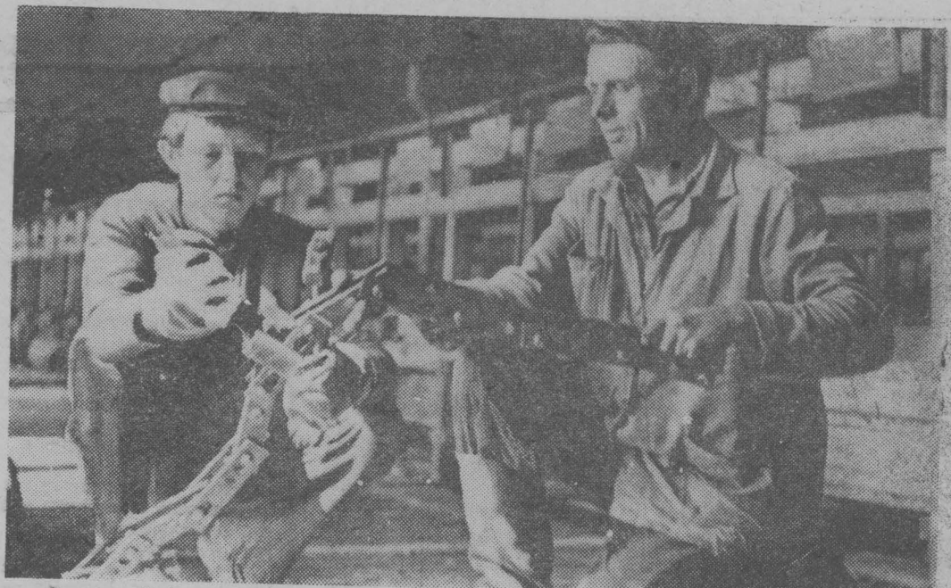
В совхозе «Безруковский» полным ходом идет ремонт животноводческих ферм. На одной из них, где побывал наш фотокорреспондент, дела подходят к концу. Здесь отлично трудится Иван Никифорович Власов. У него надежный помощник — сын
