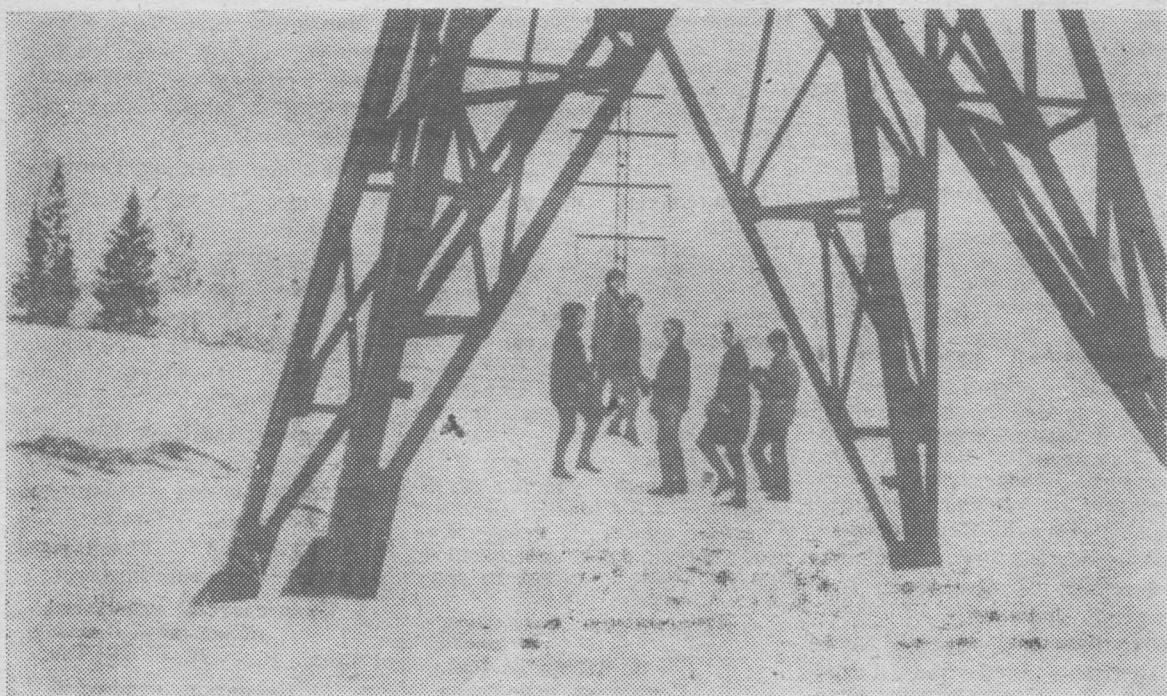
ЛЭП ШАГАЕТ ЧЕРЕЗ ТАЙГУ.
