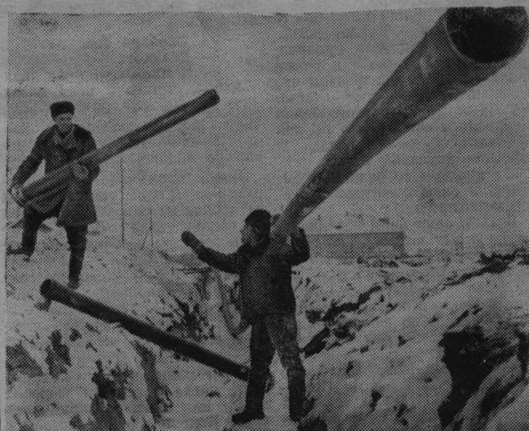
Ярославская область. На строительстве газопровода от трассы Горький — Череповец до крупной птицефабрики «Волна» не видно привычной строительной техники. А между тем три человека за день сваривают и укладывают в траншеи до 300 метров труб. Весь секрет в том, что трубы эти из полимера.
