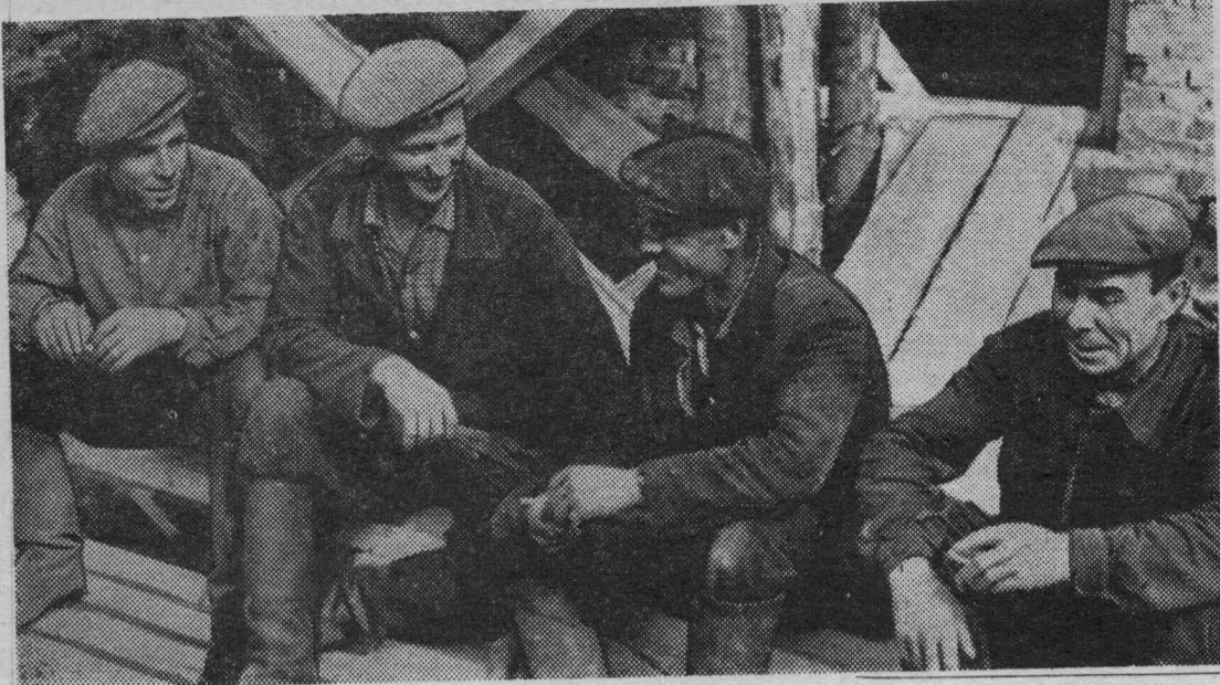
Окончен рабочий день. Можно покурить, посмеяться, подвести итог работы за день, наметить планы на будущее. А строить надо много. Тут и зернохранилище, и скотные дворы, и жилые дома. Сейчас строительная бригада совхоза «Притомский» готовит к новому учебному году Атамановскую среднюю школу. На снимке бригада плотников (слева направо): М. Н. Севергин, бригадир А. И. Царегородцев, В. Г. Проценко, В. В. Мочалов.
