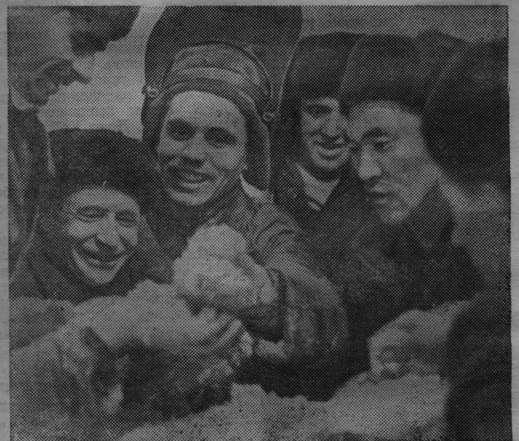
КУСТАНАЙСКАЯ ОБЛАСТЬ. Закончено строительство первой очереди (слева направо): Александр Данил-Джетыгаринского асбестового комбината. На обогатительной фабрике получены первые бело-серые хлопья с первым асбестом. На снимке: передовики ударной стройки (слева направо): Александр Данил-Джетыгаринского асбестового комбината, Пантелей Делистолян, Николай Иванов, Александр Игнатьев и Мелис Сейжанов казахстанского асбеста. Фотохроника ТАСС.
