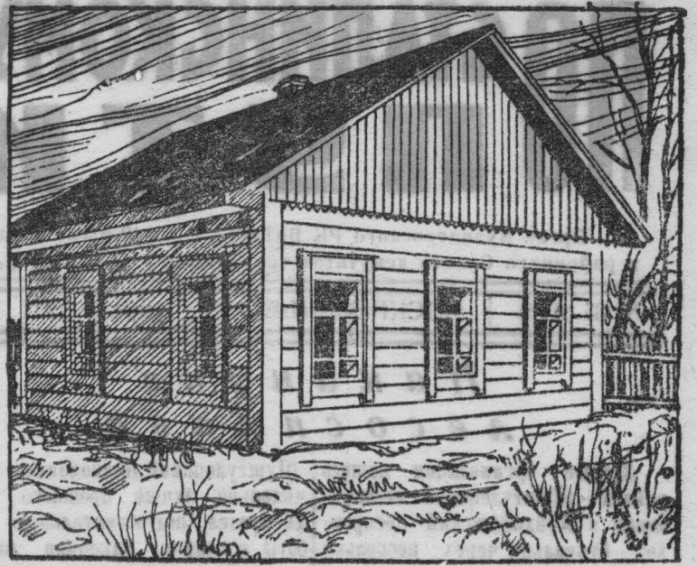
Колхозы Косихинского района, Алтайского края, хорошо готовятся к встрече переселенцев, строят сотни новых домов. На снимке: вновь построенный дом для переселенцев.
