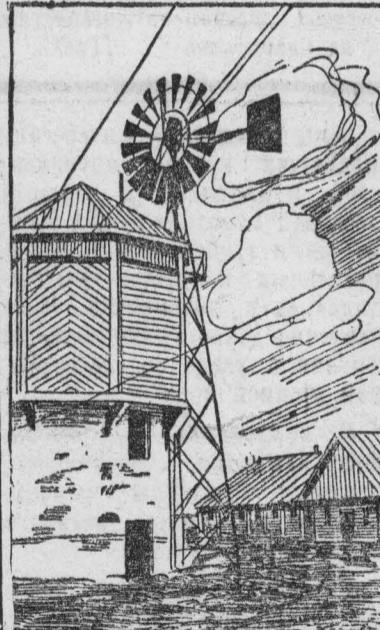
Большое строительство развернулось в мясо-молочном совхозе Топкинского района. В 1940 году построены: водонапорная башня с ветродвигателем мощностью в 5 тысяч ведер воды в час, скотный двор на 100 голов, кирпичный телятник, два склада, три жилых дома на 12 квартир. На снимке: водонапорная башня с ветродвигателем, на втором плане — новый скотный двор. С фото А. Соломахина.
