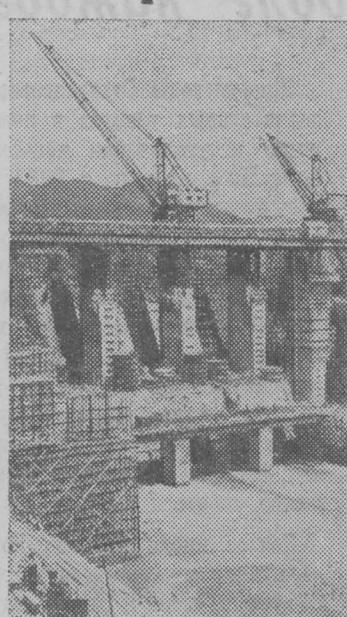
Китайская Народная Республика. На реке Синьцзян в провинции Чжэцзян сооружается гидроэлектростанция мощностью 650 тысяч киловатт. Созданная по проекту китайских инженеров станция даст первый ток в конце 1959 года.
