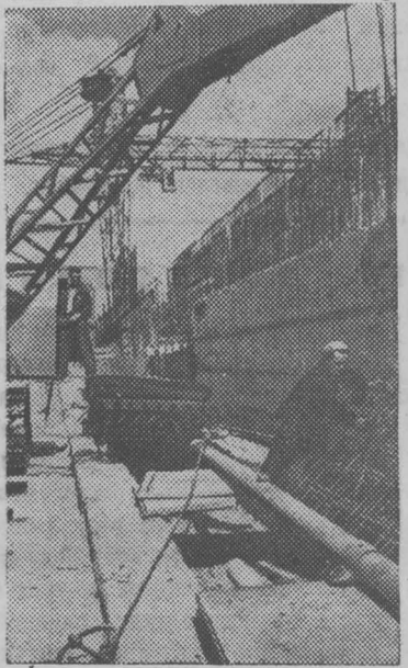
Строительство Воронежской атомной электростанции. Монтаж арматуры.
