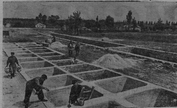
Крымская область. Колхоз имени Сталина Симферопольского района заканчивает строительство силосных сооружений. Уже облицованы траншеи емкостью 1.200 тонн. Строительная бригада Н. Я. Морозова ежедневно опережает график работ на облицовке и цементировании траншей.
