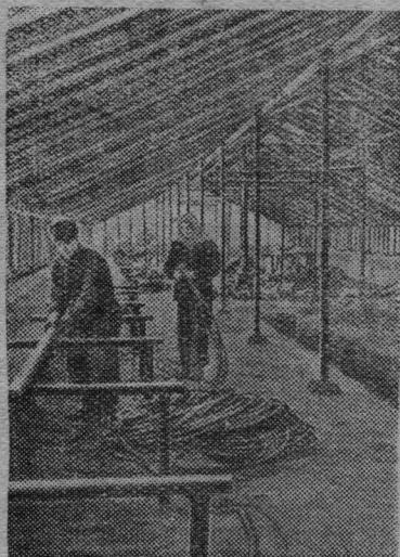
Ленинградская область. Работники Невского машиностроительного завода имени В. И. Ленина шествуют над сельхозарте́лью имени Маленкова Лужского района. Большую помощь оказывают шефы колхозу в строительстве теплиц и парников на две тысячи рам с водяным обогревом.
