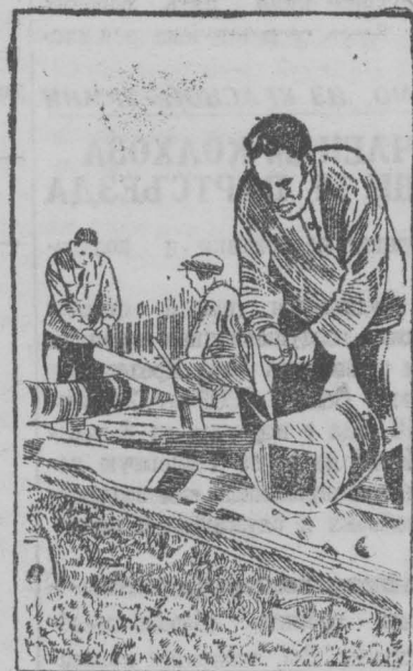
На снимке: строительство зернохранилища в Шубинском мясокомбинате, Баранского района, Новосибирской области. На первом плане плотник тов. М. Н. Федоров.
