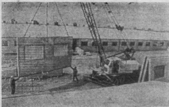
Белорусская ССР. Сократить сроки возведения животноводческих помещений коллективу Слуцкого сельского строительного комбината помогает высокий уровень заводской готовности конструкций. Выпуск на предприятии стеновых блоков с вмонтированными окнами, комплексных плит покрытия, различных железобетонных изделий позволил добиться индустриализации сборки зданий.
