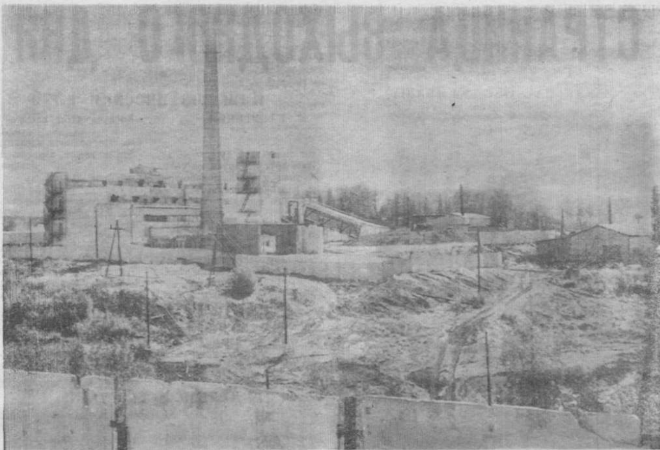
На этом фотоснимке вы видите новую котельную теплоснабжения, которая отныне будет обслуживать поселок гидростроителей. Недавно члены государственной комиссии утвердили акт о приемке этого важного объекта в эксплуатацию. А сегодня коллектив эксплуатационников КВТС-1014 занят подготовкой к работе в зимний период.
