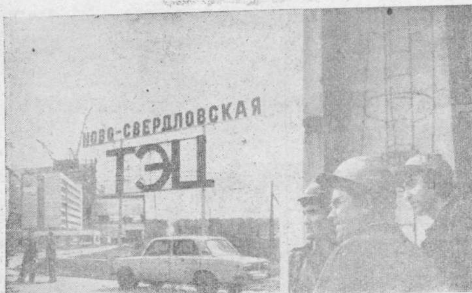
Свердловская область. Отлично трудится на строительстве Ново-Свердлов-
