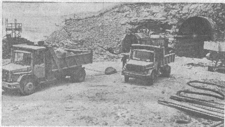
Бурятская АССР. На западном участке Байкало-Амурской магистрали в отрогах Байкальского хребта начата прокладка основного ствола семикилометровой Байкальской тоннели — одного из самых крупных на трассе. Работы ведет сквозная бригада кавалера ордена Ленина московского метростроевца Валентина Толстоухова из управления «Бамтоннельстрой».
