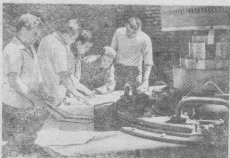
Туркменская ССР. 900 тысяч гектаров засушливых земель Каршинской степи в этом году получают живительную влагу Амударьи. На трассе 106-километрового Ульяновского оросительного канала гидростроители ведут монтаж водоподъемных агрегатов на насосных станциях.
