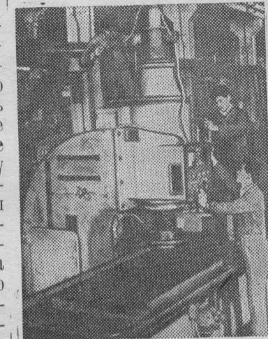
Китайская Народная Республика. На Шанхайском станкостроительном заводе изготовлен первый в стране шлифовальный станок, предназначенный для точной обработки поверхности. —
