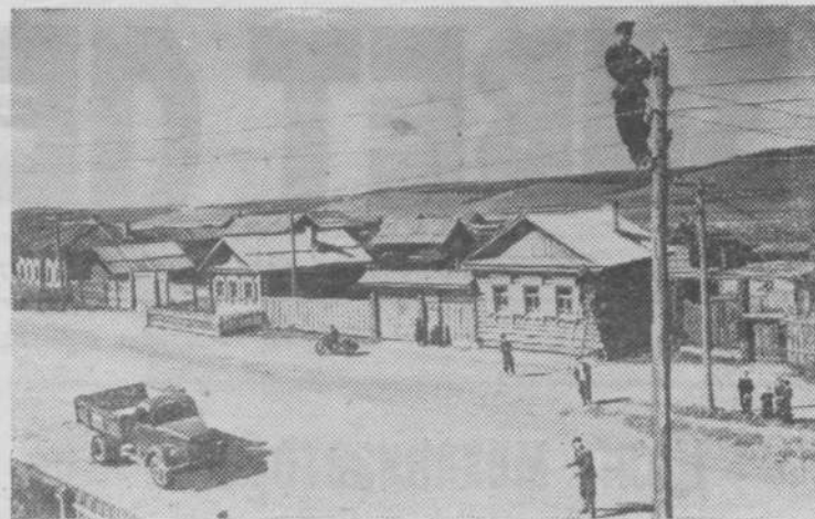
Иркутская область. В текущем году от Иркутской ГЭС получат электроэнергию все колхозы и совхозы Зининского района. В сельскохозяйственной артели имени Ленина работает бригада монтажников Черемховского «Сельэлектро». Она уже смонтировала высоковольтную линию пе-
