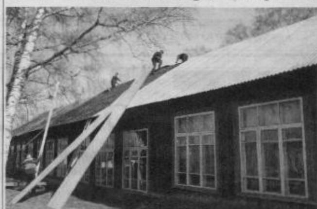
Кровля садика находилась практически в аварийном состоянии, постоянно протекала. Там местами был сломан шифер. Если со стороны главного входа крыша разрушилась лишь частично, то со двора - практически полностью, так как здесь постоянно скапливается снег, создавая дополнительную нагрузку на листы. От этого просели стропила, погнувшись обрешетку.
