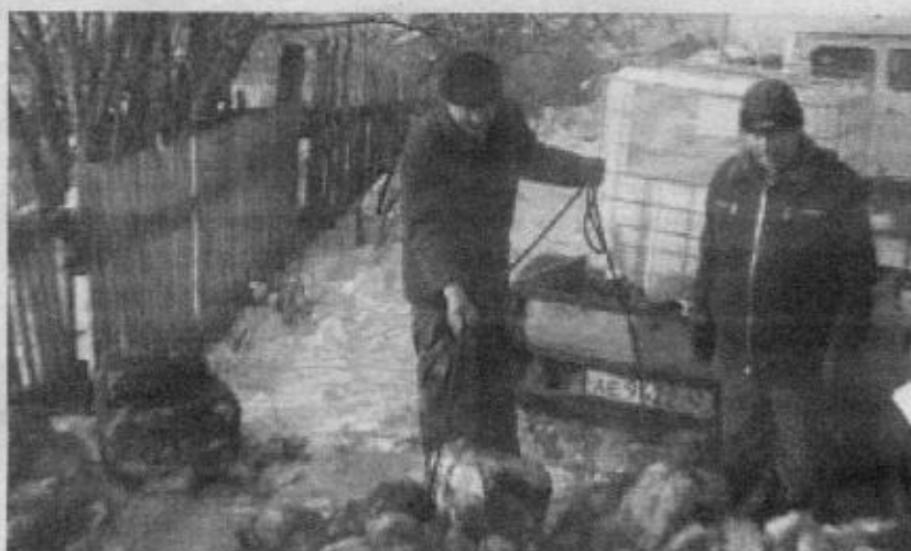
Рабочие ООО «ВКУ» отогревают водопровод на ул. Степной.
