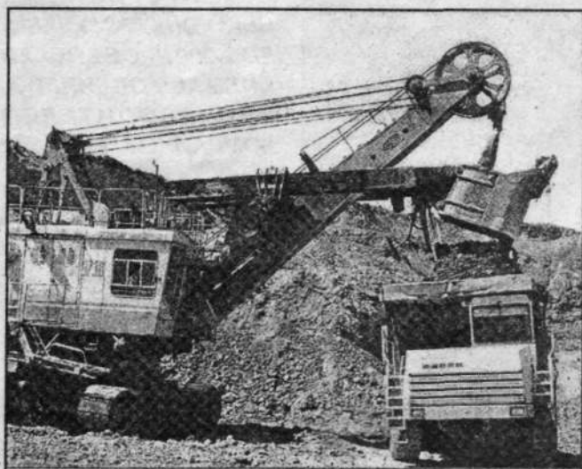
Вскрышные работы на Еловском разрезе
