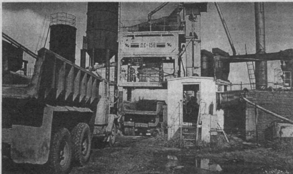
Выпуск асфальтобетонной смеси
