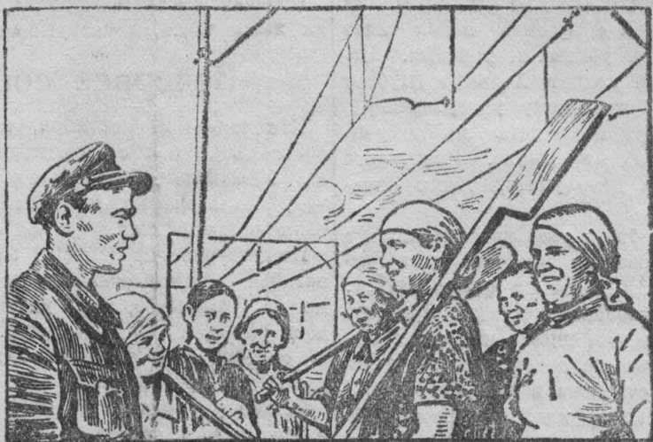
Домохозяйки 3 околотка Н.-Кузнецкой дистанции пути систематически принимают участие в работах по ремонту пути. На снимке: дорожный мастер М. В. Спицин дает указания группе домохозяек, направляющихся на работу. «Советская Сибирь». С фото Ф. Гичку.
