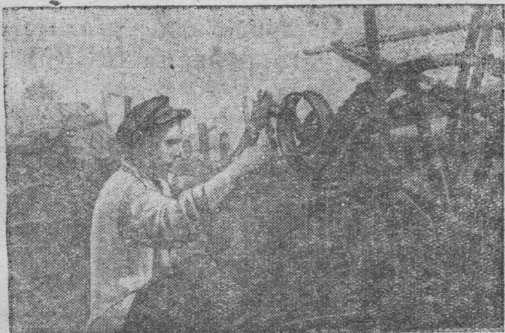
Колхоз имени Парижской коммуны (Красноусольский район, Башкирская АССР) заканчивает ремонт уборочного инвентаря. Кузнец В. И. Сайфуллин ремонтирует лобогрейку.
