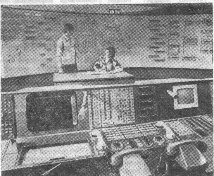
На шахте имени А. Г. Стаханова создан участок автоматизированных систем управления производством — АСУП. Они ведут табельный учет спуска горняков под землю, анализируют работу угледобывающих комплексов, учитывают и контролируют производственные процессы, безопасное ведение добычи под землей.
