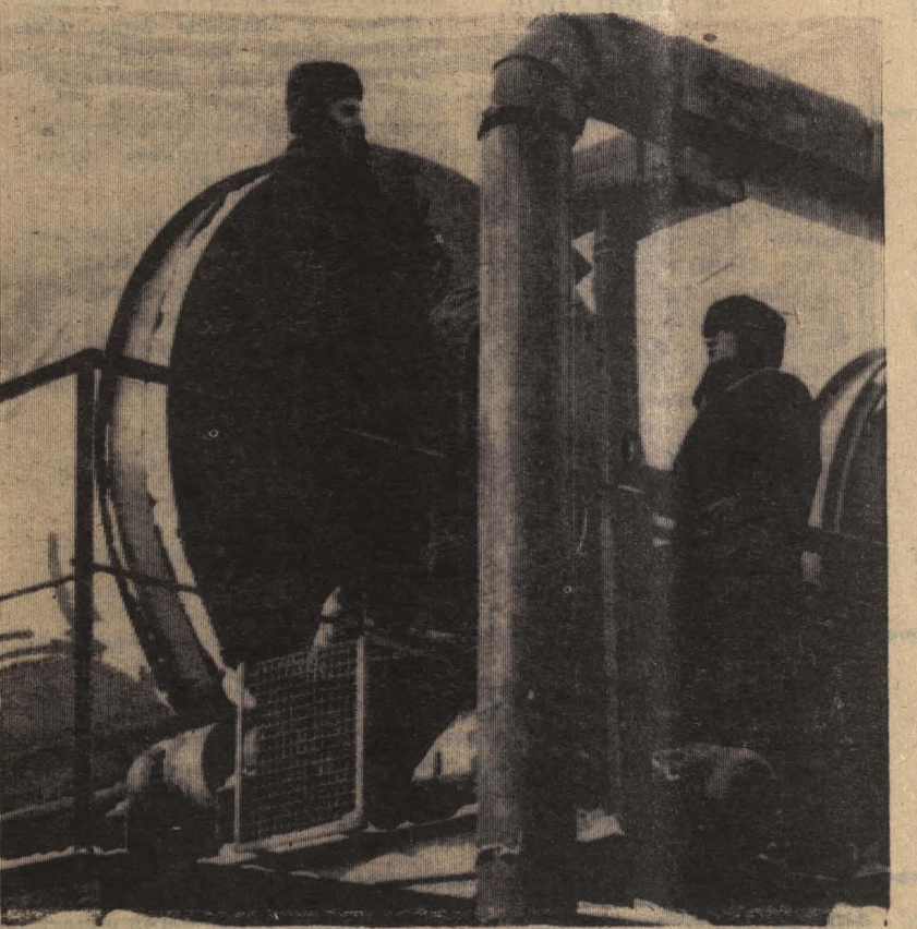
ИДЕТ МОНТАЖ КОРМОЦЕХА В КОЛХОЗЕ «ПРОГРЕСС».
