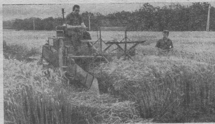
Краснодарский край. На опытных полях и делянках Краснодарского научно-исследовательского института сельского хозяйства проходит испытания комбайн-малютка. Он создан сотрудниками опытного конструкторского бюро Сибирского научно-исследовательского института сельского хозяйства.
