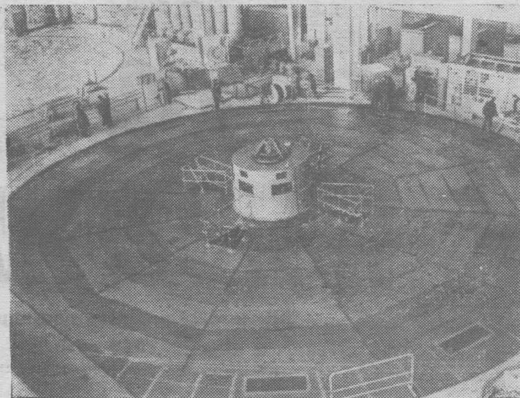
Строители крупнейшей в мире Красноярской ГЭС смонтировали и пустили десятый агрегат. Решено ввести в эксплуатацию дополнительно еще два агрегата — одиннадцатый и двенадцатый. Мощность гидроэнергетического гиганта на Енисее составит 6 миллионов киловатт.
