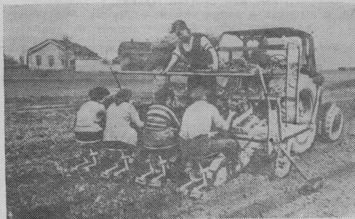
ГЕРМАНСКАЯ ДЕМОКРАТИЧЕСКАЯ РЕСПУБЛИКА. На народном предприятии Боденбайрбайтунгстерте в Лейпциге создана новая машина для посадки растений, черенков и картофеля. За час с помощью агрегата может быть высажено от 7 до 10 тысяч растений. Фото Центральбильд—ТАСС.
