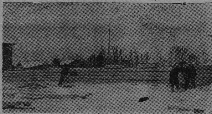
На строительной площадке Дома пионеров в пос. Ижморском. Фото Г. Лучевникова.
