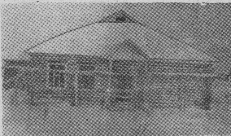
Хорошую новую школу с паровым отоплением получают к осени 1960 г. школьники с. Берикюль. На снимке: строящееся здание школы.
