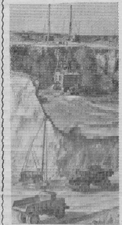
ОРЕНБУРГСКАЯ ОБЛАСТЬ. На базе богатейшего месторождения медных руд сооружается Гайский горнообогатительный комбинат. Добыча медной руды будет осуществляться двумя способами — открытым и подземным. В изстоящее время полным ходом идет вскрыша карьера. Горняки оснащены мощной современной техникой.
