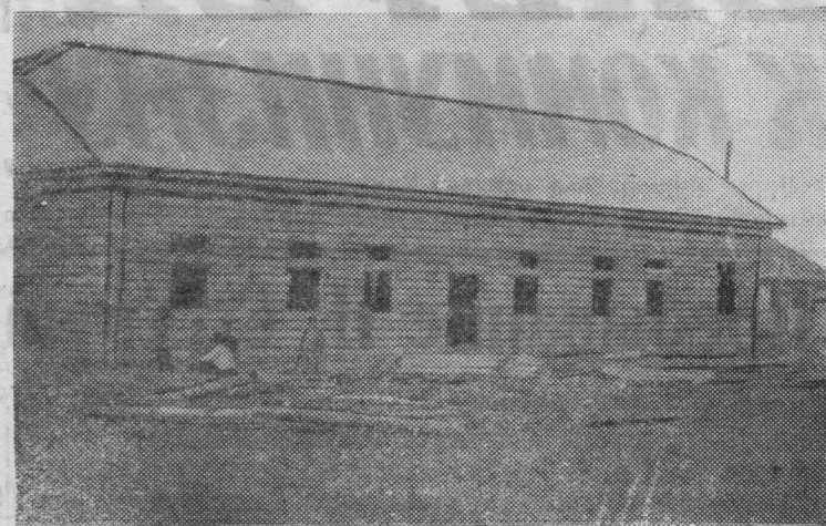
В этом году жители села Бекет получают от строителей новый клуб. Строительство его и внутреннюю отделку намечено закончить к празднику Октября.
