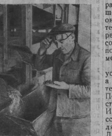
КРАСНОДАРСКИЙ КРАЙ. Механик зерноочистительных машин колхоза «Россия» Белореченского района Л. Т. Халиевкин много работает над усовершенствованием зерноочистительной машины. Сначала он усилил карбовую систему вертикальных транспортеров. Вместо 3 тонн зерна в час машина стала перерабатывать 18 тонн. Затем он изготовил и подсоединил к машине ряд механических транспортеров, подающих зерно в бункера, а отходы — в отведенное место.
