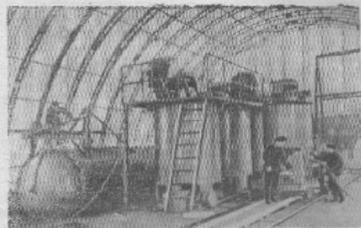
Московская область. Новый цех на Павшинском механическом заводе называется несколько необычно — стационарный цех газобетонных изделий.
