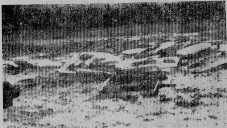
Для строительства летней танцевальной площадки, которую планируется сделать за районным Домом культуры, два года назад завезены дорогостоящие железобетонные плиты. Строители свалили их в кучу и на этом поставили точку. Портится материал на большую сумму, а заботы о нем нет.
