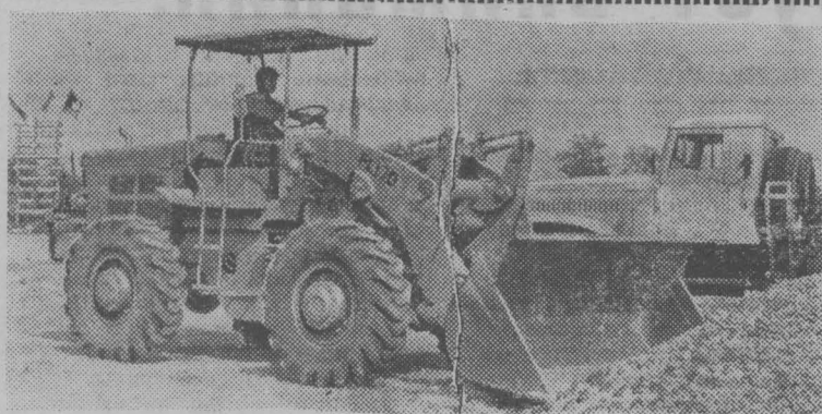
ЛНДР. В Тагоне близ Вьентьяна при содействии Советского Союза началось строительство ремонтной мастерской сельскохозяйственной техники.
